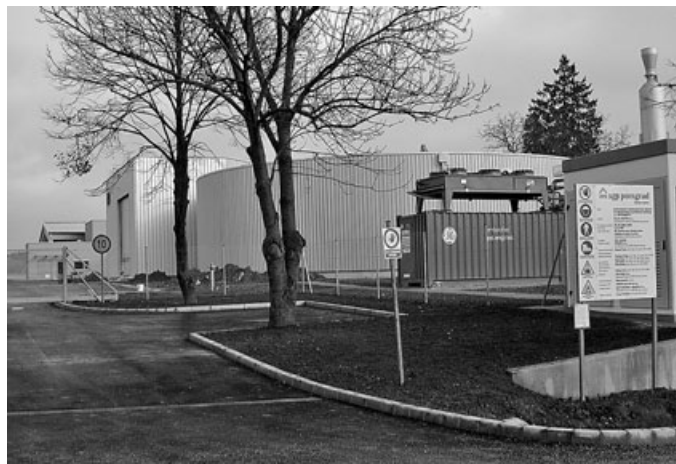
Gradnja bioplinarne v Motvarjevcih je bila zaustavljena tik pred začetkom poskusnega obratovanja. Na zahtevo civilne iniciative je prišlo do obnove postopka za izdajo gradbenega dovoljenja.
