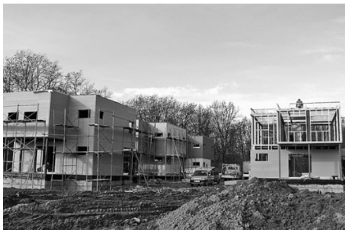
Novogradnje v Noršincih – ob vpadnici v občino iz soboške strani nastaja naselje Sončna jasa. Kanalizacijski in vodovodni priključki se bodo navezali na obstoječe omrežje v kraju.
