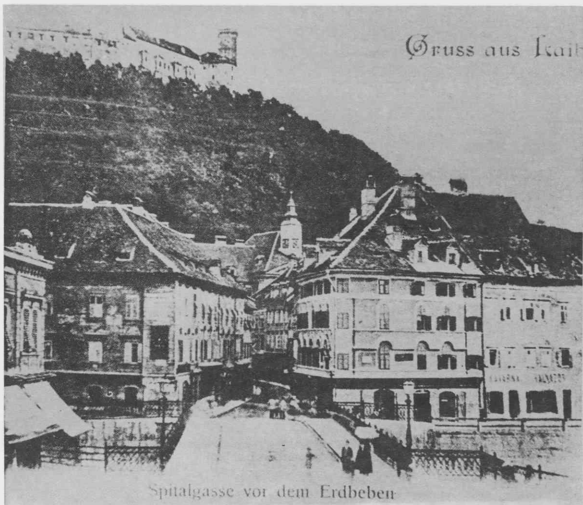
Pogled na Špitalsko ulico pred potresom
