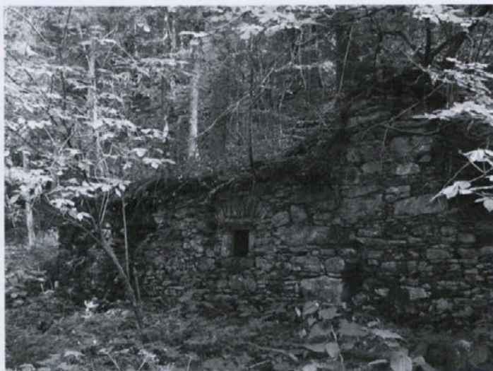
Ruševine Bežjakovega mlina, h. št. Črna 3, na bivši posesti Rupnkovega "grunta". Foto: Janko Rupnik
