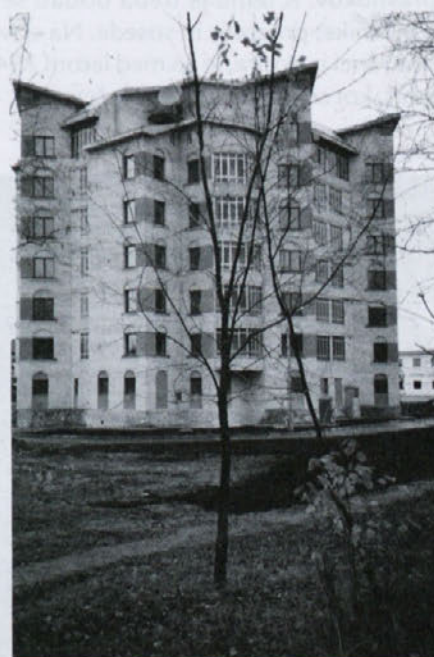
Montirana okna na objektu. Foto: Rihard Bogataj
