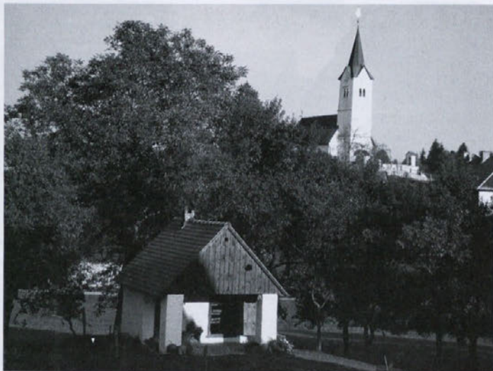
Pajšt po obnovi. Foto: Vanja Leskovec
