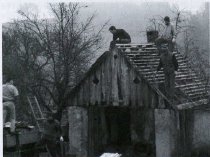
Začetki obnove. Foto: Vanja Leskovec
