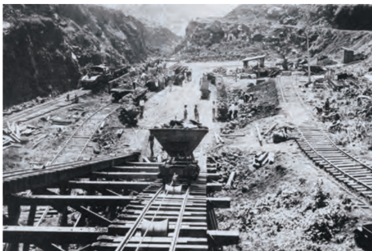
Gradnja Panamskega kanala leta 1907. Vir: Google slike.
