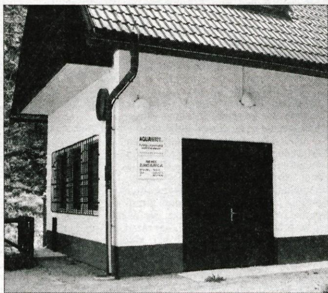
Mala hidroelektrarna Žingarica na potoku Završnica.
