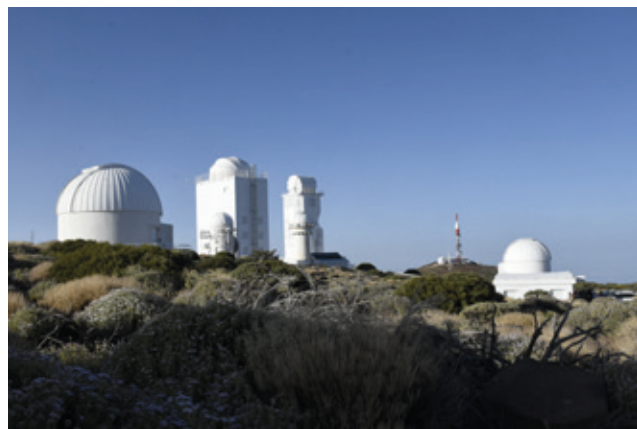
Slika 4: Del verige teleskopov na observatoriju Teide: Center za obiskovalce, največji evropski (nemški) 1,5-metrski sončni teleskop Gregor, nemški 70-centimetrski teleskop VTT z vakuumskim stolpom in manjši belgijski 50-centimetrski teleskop MONS, gledano od leve proti desni. (Foto: R. Snoj.)
