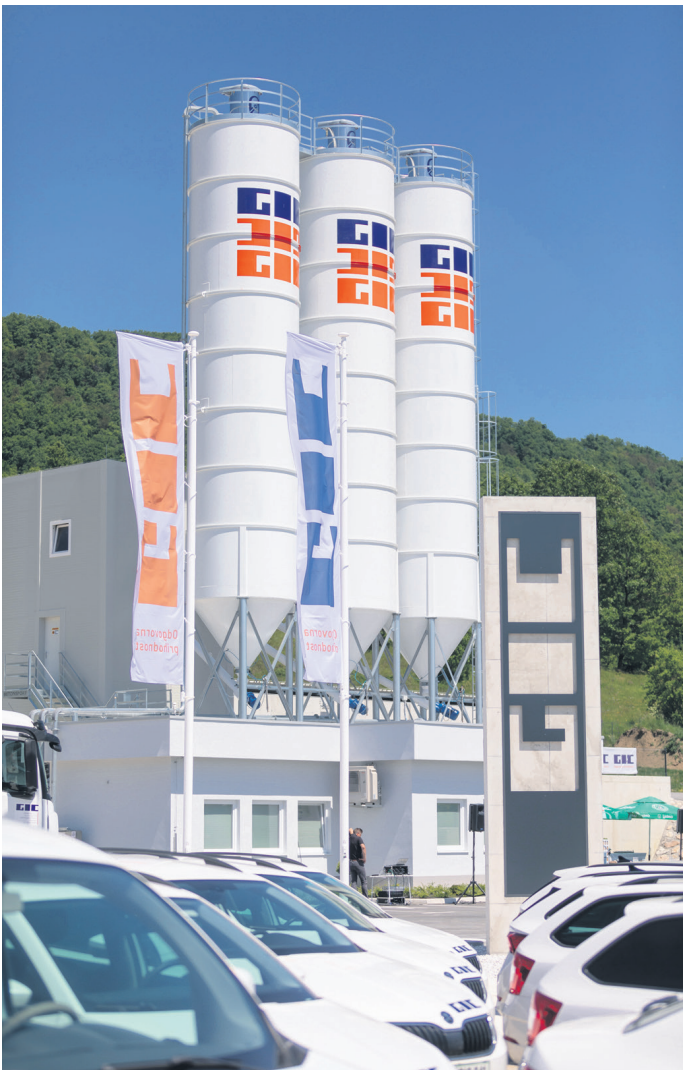
Slatinsko podjetje Gic gradnje je postavilo najbolj sodobno in napredno betonarno v Sloveniji. Ima v celoti digitalno vodene procese, v katere je vključena tudi umetna inteligenca. (Foto: arhiv NT/Nik Jarh)
