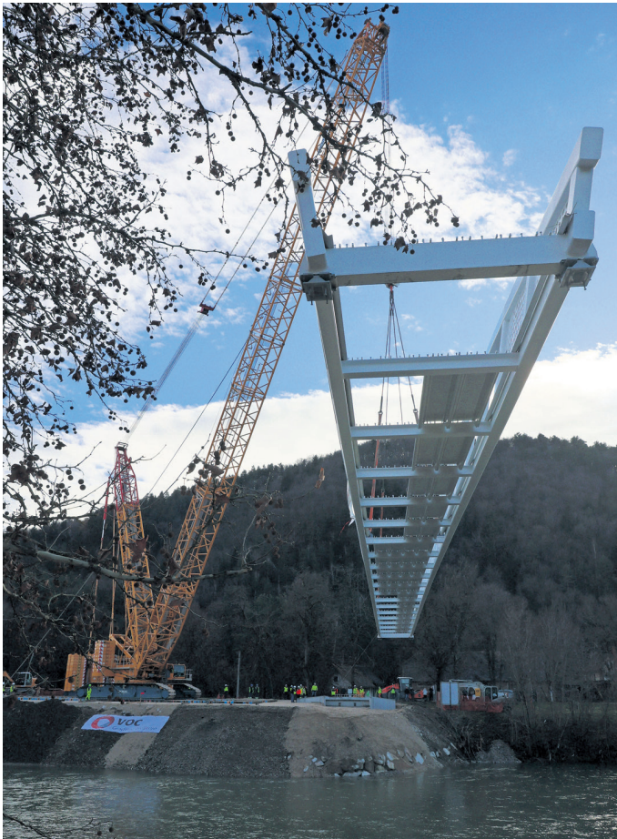
Eden odmevnejših projektov, o katerem smo letos poročali, je bila zagotovo postavitev 123-tonskega kolesarskega mostu čez Savinjo. Jeklena konstrukcija mostu je del kolesarske povezave Celje–Žalec. (Foto: Andraž Purg)
