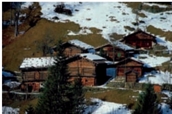
Fig. 1: Buildings in the blockbau system in Valle del Vanoi. Zgodbje zgrajene v kladni zvezi, Valle del Vanoi.
