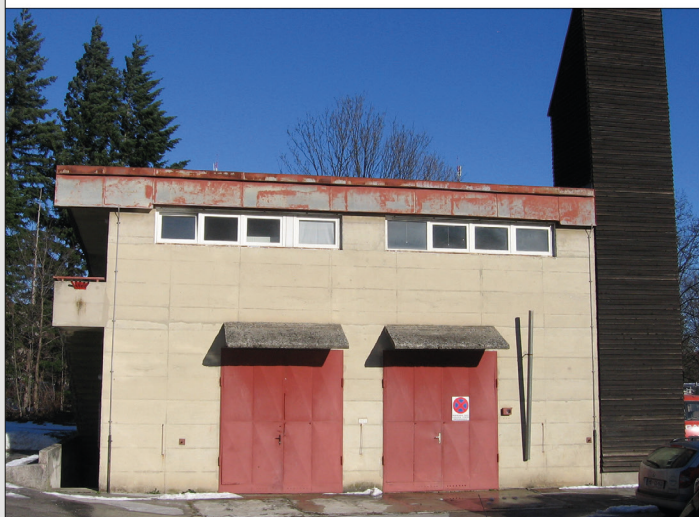
Stavba gasilskega doma PGD IC Konus
