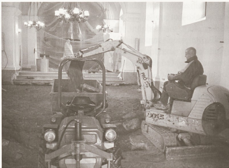
Na sliki: Izkop starega kamnitega tlaka Foto: Jože Velikonja
