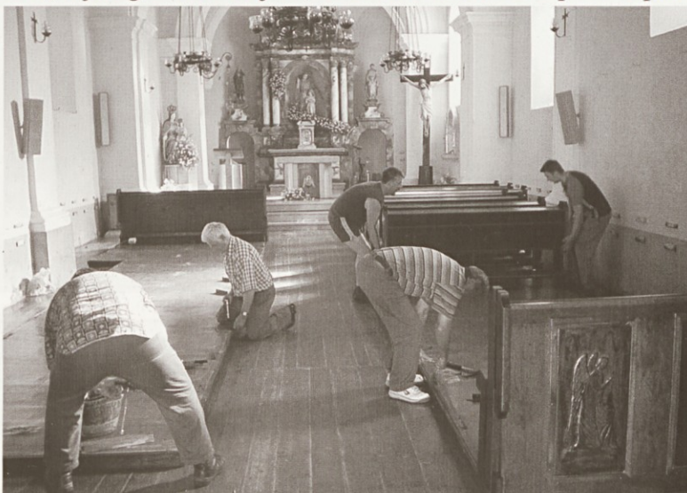
Na sliki: Demontaža klopi in lesenega poda
