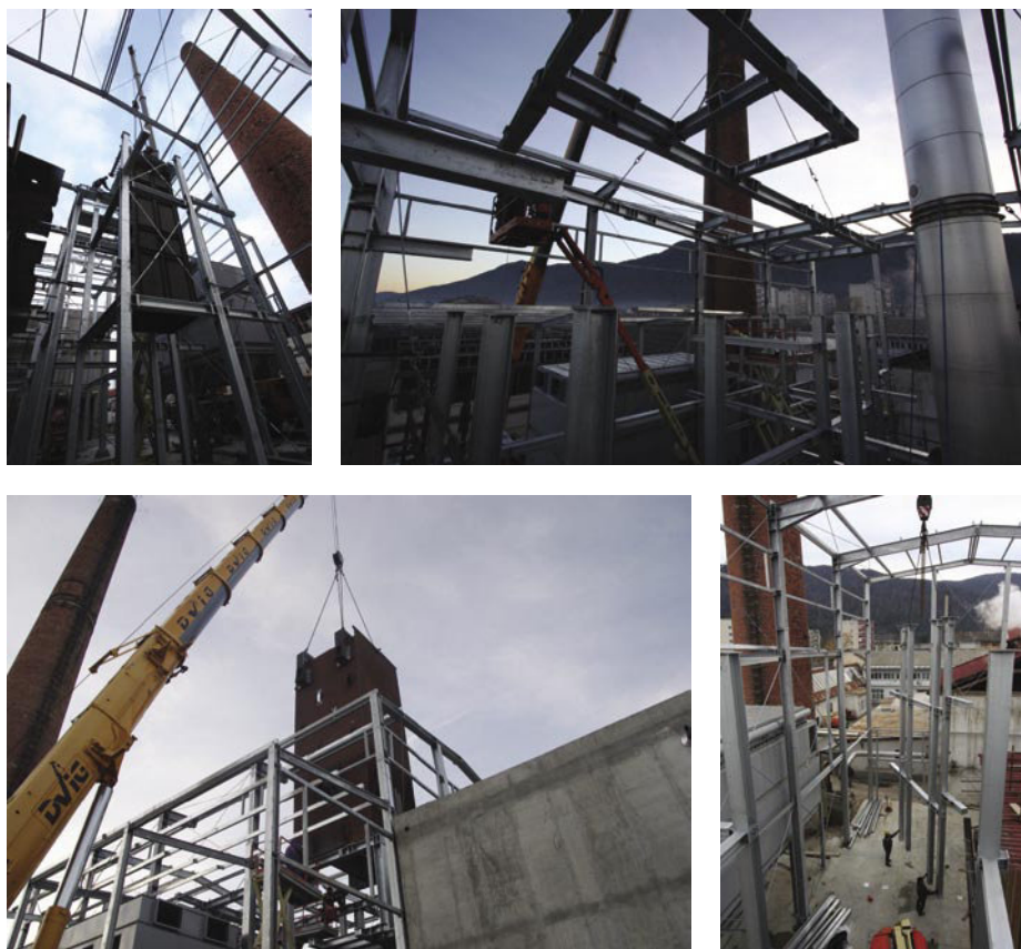
Slika 11 • Montaža jeklene konstrukcije kotla in večjih delov kotlovske tehnološke opreme
