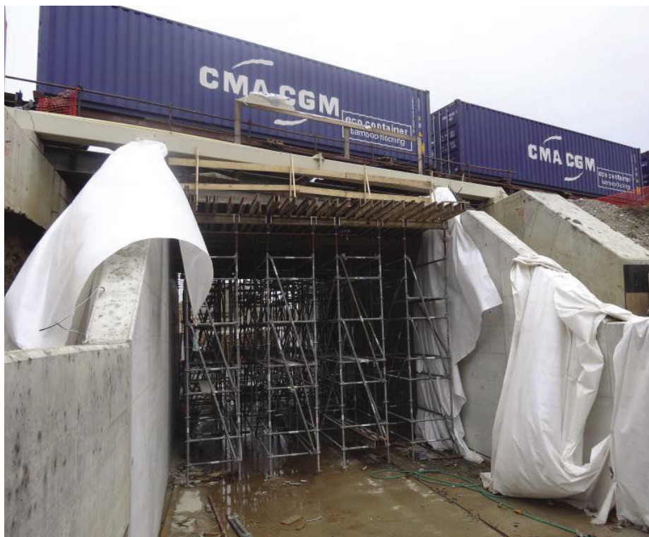
Slika 1 • Gradnja AB-podvoza Jablane (Fotografija: Jože Preskar)
