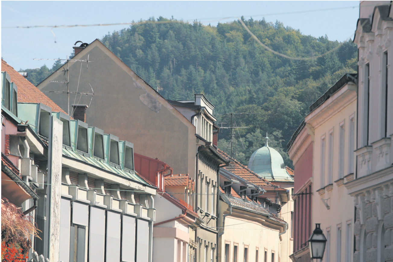
Med območja, kjer so padavinske vode s streh v celoti speljane v kanalizacijo, je tudi staro mestno jedro.
