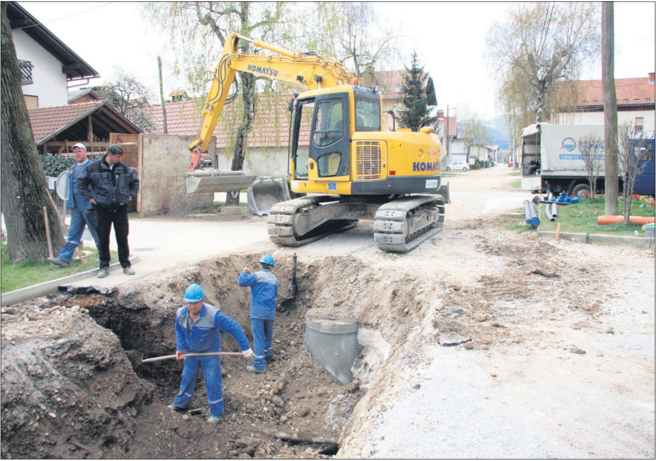
Občina Žalec je zaključila gradnjo kanalizacije v KS Petrovče. Sedaj so na vrsti še nekoliko bolj oddaljena naselja od že zgrajenih kanalizacijskih sistemov.
