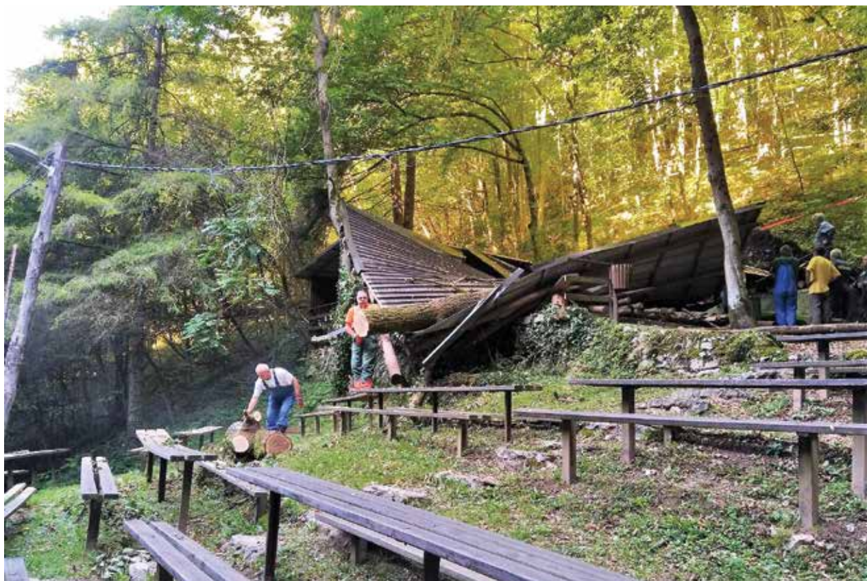
Odstranjevanje padlega drevesa
