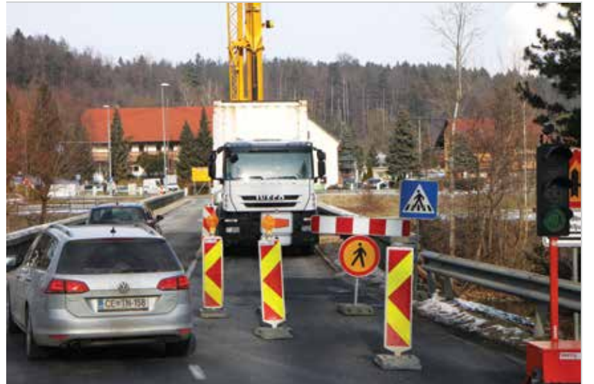
Dela so se začela, promet je urejen izmenično s semaforjem.
