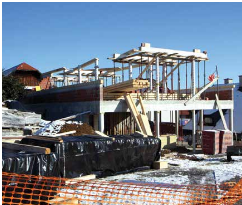
Gradnja novega avtosalona
