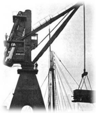
Slika 1 : Pristaniščni hidravlični žerjavi: Armstrongov žerjav (levo) in Armstrong-Mitchellov žerjav (tehnična zapuščina – Arsenal, Benetke) (desno) [2] do [5]
