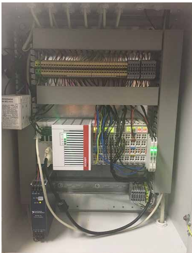
Slika 5 : Krmilnik Beckhoff CX5140 z vhodno-izhodnimi moduli
