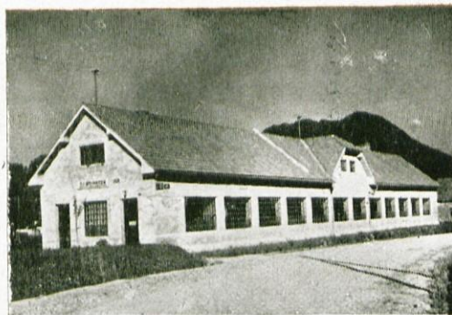
Škofja Loka: Podjetje za zgradbo vodnih turbin G. F. Schneider, ki je edino svoje vrste v dravski banovini
