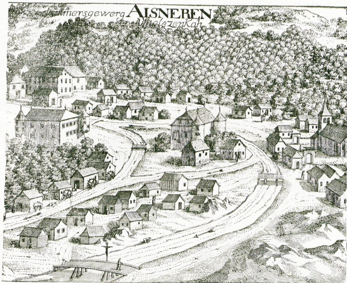
Železniki v Valvazorjevi dobi
