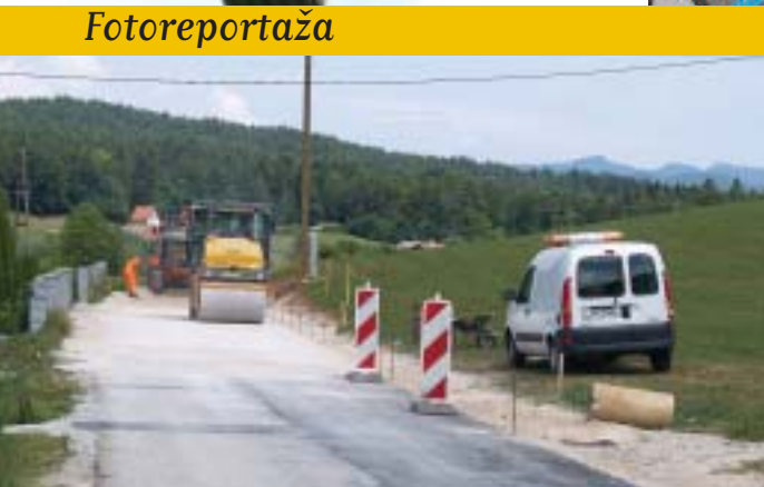
Prenova ceste v Šinkovem Turnu
