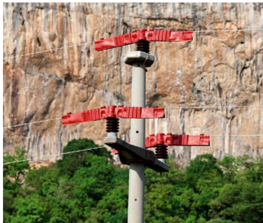
Primer izolacije kritičnih delov sredjenapetostnega daljnovoda na Krasu foto: vse Tomaž Mihelič
