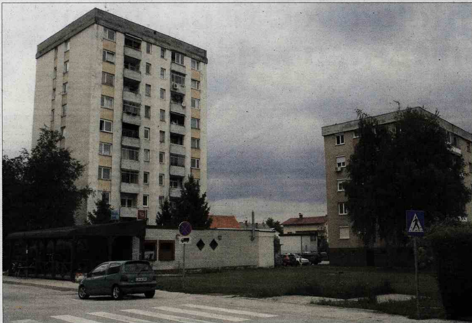
Na mestu obstoječega gostinskega lokala je že po sedaj veljavnem zazidalnem načrtu predviden manjši stanovanjski objekt, vendar je želel lastnik Ervin Simonič postaviti kar štirinadstropno poslovno-stanovanjsko stavbo. Za krajanje to ni sprejemljivo. (Foto: GrupA)
