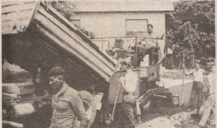
ASFALT SKOZI PODZEMELJ — Vse do asfaltiranja 1.300 m ceste skozi Podzemelj proti Kučarju so vaščani naredili s svojim delom in denarjem. Zbrali so 5,2 milijona dinarjev in opravili več kot 3.000 delovnih ur. (Foto: A. Bartelj)
