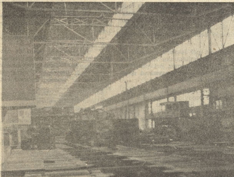
Montaža prog v novi valjarni
