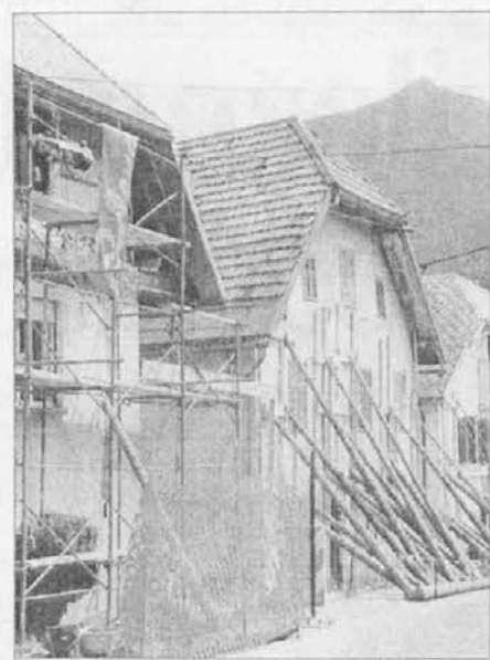
Gradbena dela v bovški Mali vasi
