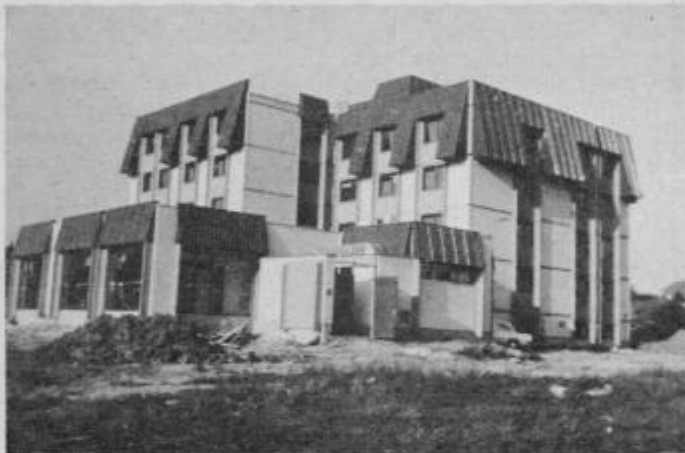
V neposredni bližini Centra srednjega usmerjenega izobraževanja v Ptuj se ponosno dviga novi dom učencev. Vsa glavna gradbena dela so že končana in dom bo že to jesen sprejel svoje prve stanovalce.
