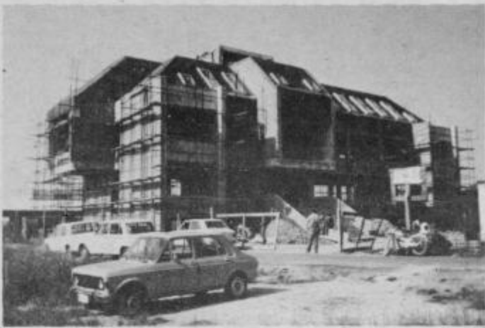
Ob Ormoški cesti v Ptuj je nova poslovno-tehnična zgradba TOZD Elektro Ptuj že pod streho. Vsa gradbena dela so v zaključni fazi. Gradbeno podjetje Gradis TOZD Gradnje Ptuj bo dela opravilo v roku.
