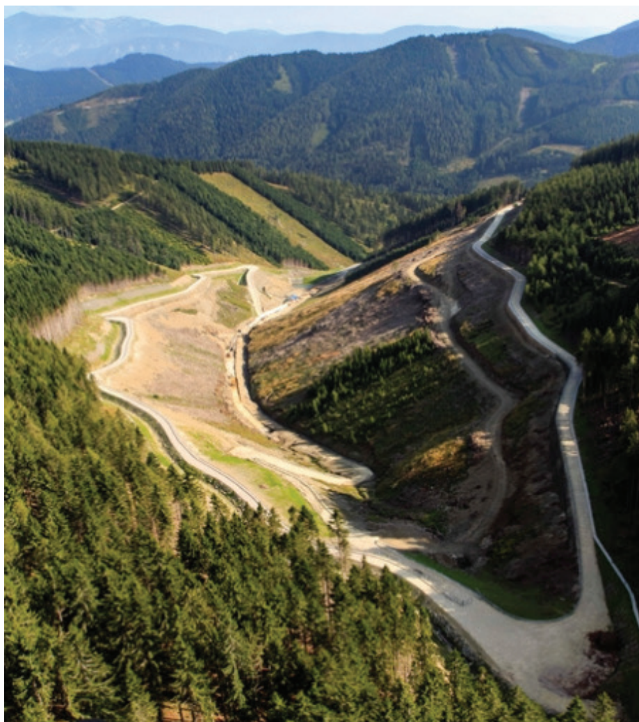
Slika 3 • Deponija Longsgraben ob gradnji. (Vir: https://igt-engineering.com/projekt/semmering-basistunnel-planung/ , 2017)
