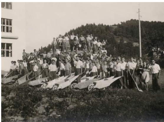
Alpinini udarniki pri gradnji tovarne. Fototeka Alpina.
