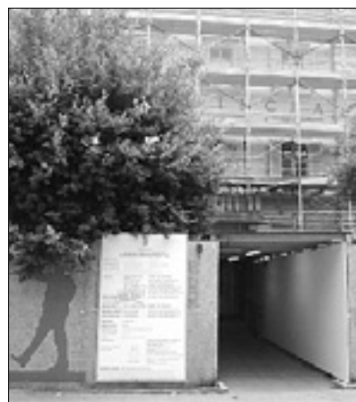
Gradbišče na Korzu
