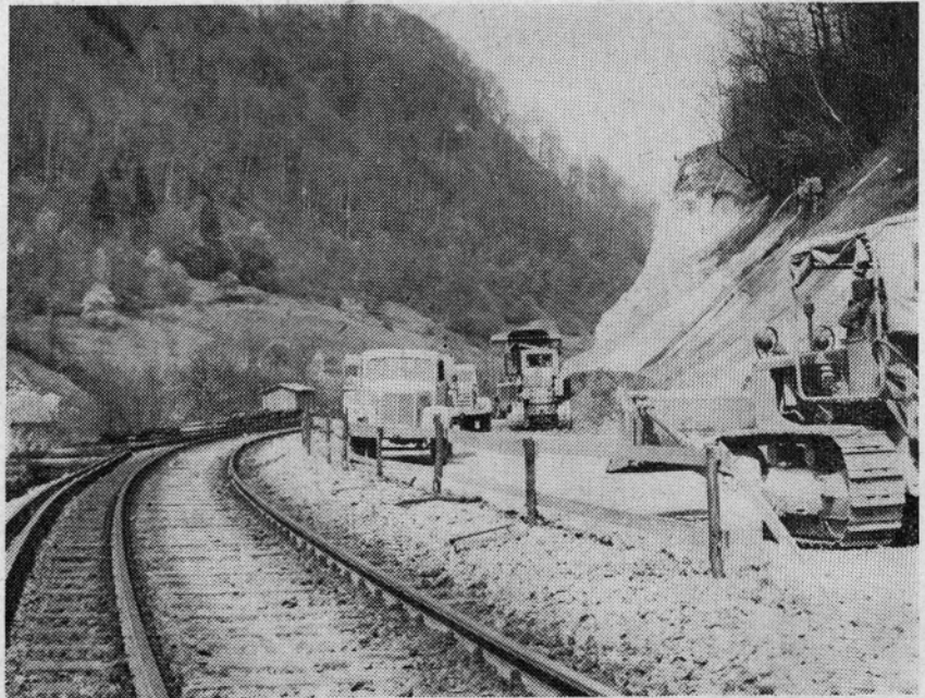
Na železniškem odseku Zidani most—Radeče s težko mehanizacijo odstranjujejo del skalnatega hriba, da bi izravnali dosedanjo krivino
