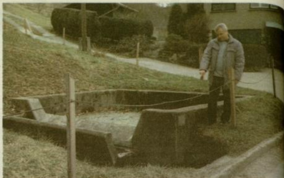
Nekoč lepo urejeno perišče v zaselku Toplice pri Štorah, ki ga bogati topla voda. Štorčan Srečko Križanec razmišlja, kako izkoristiti toplo vodo, ki ima tudi pozimi 16 stopinj Celzija.
