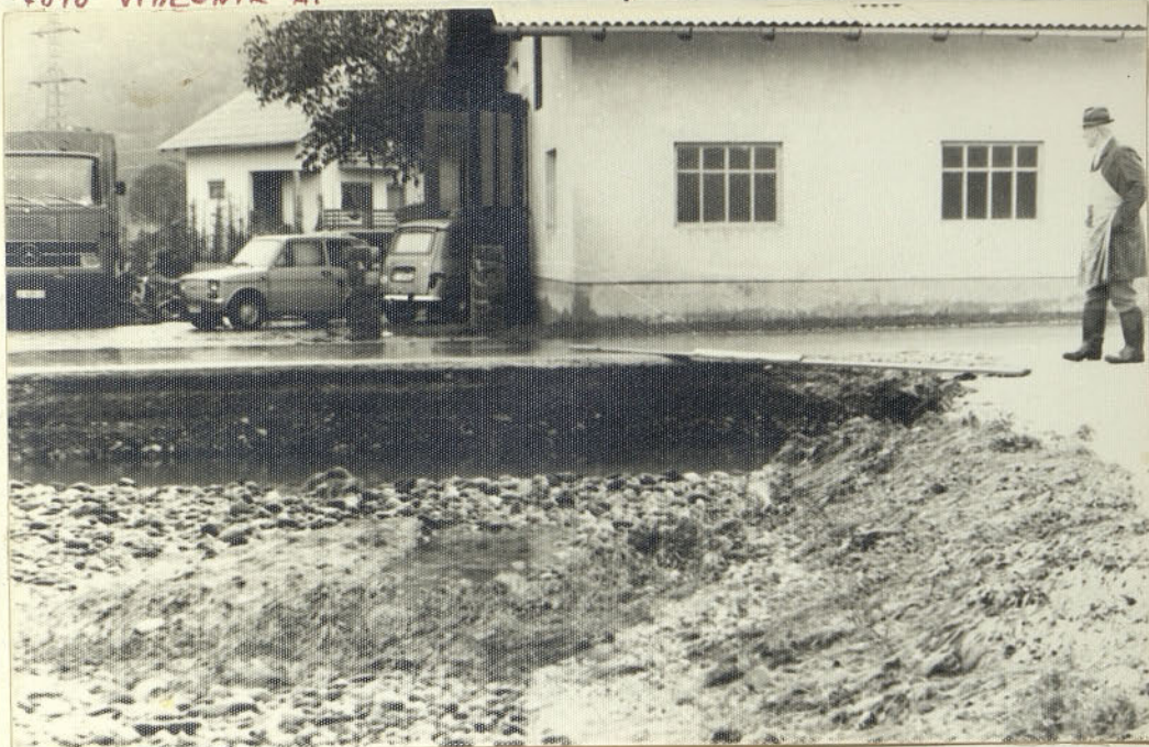
Spodjedena asfaltna cesta proti Lokam
