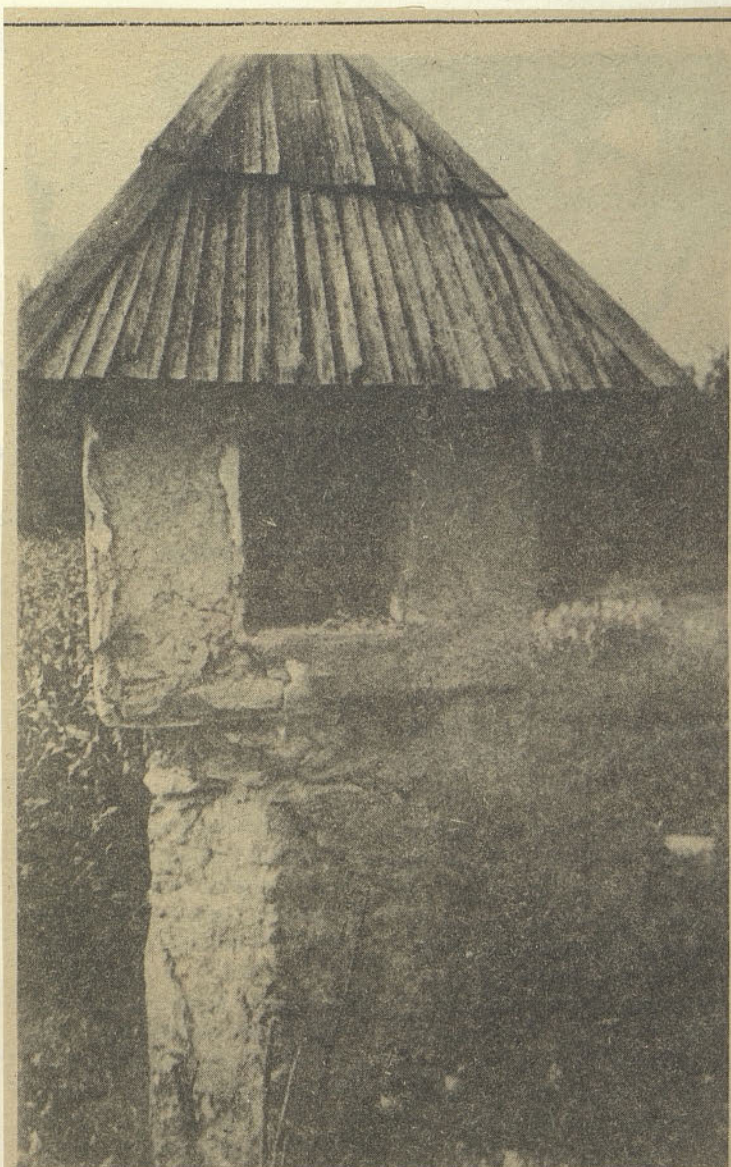
Poškodovano kužno znamenje v Ljubiji
