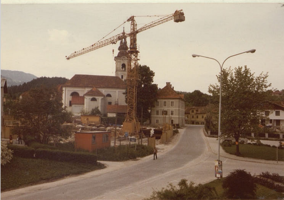
Pogled na gradbišče maja 1980
