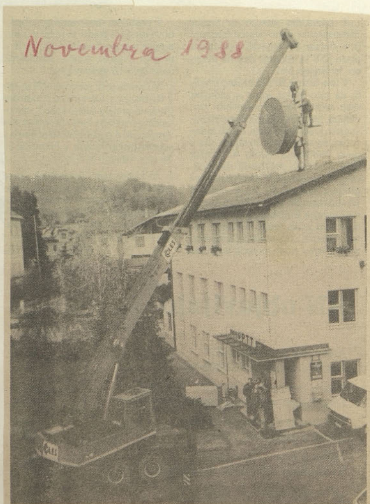
Na strehi mozirske pošte se že nekaj dni bohota velika antena za radio-relejno povezavo Sv. Križ — Mozirje — Celje, ki bo omogočala 300 brezžičnih medkrajevnih telefonskih zvez za Zgornjo Savinjsko dolino. Ta antena je bila pogoj za vključevanje končnih avtomatskih telefonskih central v vozliščno centralo v Mozirju in naprej v glavno centralo v Celju. Antena je bila v celoti financirana iz sredstev samoprispevka, vrednost antene pa je 70 milijonov din.
