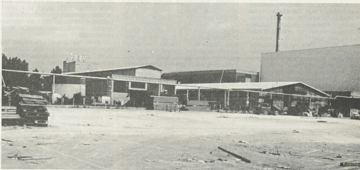
Skladišče surovin in pomožnega materiala gradi SCT-TOZD Inženiring kot najugodnejši ponudnik. Stroji za zemeljska dela so pričeli brniti že meseca septembra in upati je, da bomo res že do zime pridobili prepotrebna pokrita skladišča, kot so obljubili izvajalci. Naša fotografija je nastala tik pred začetkom gradbenih del na izpraznjeni ploščadi
