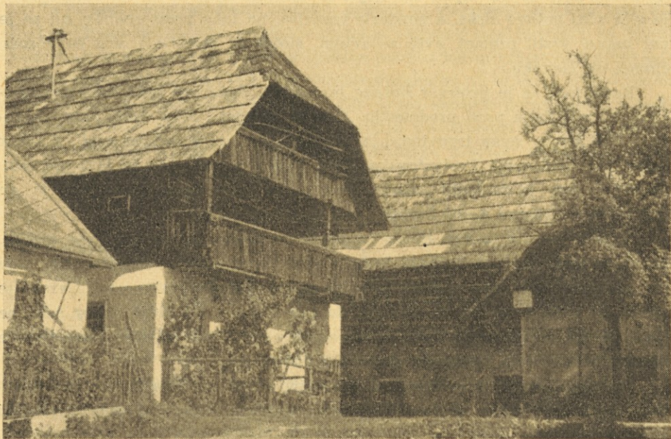
Vedno manj je kmečkih domačij starega sloga, kot jo kaže slika z žihpoljske vasi Ingarje nad Celovcem
