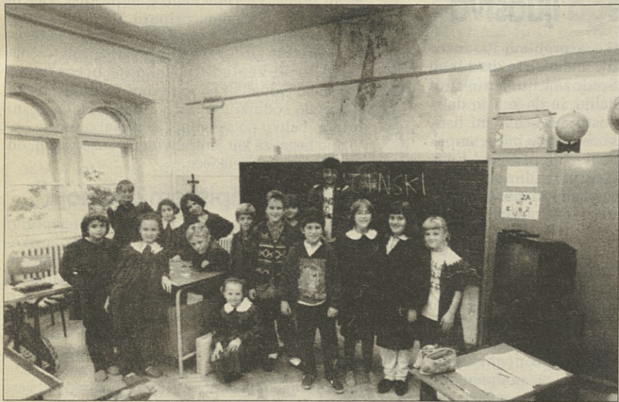
Učilnica v prvem nadstropju v katero ob deževju pronicava voda (f. KROMA)
