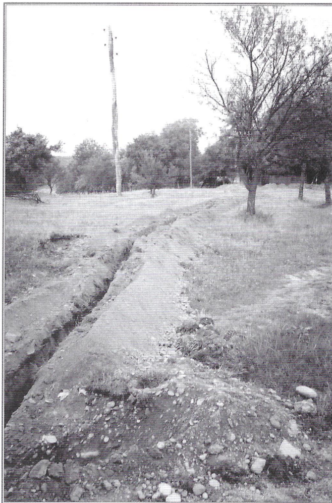
Polaganje vodovoda v naselju Gibina.
