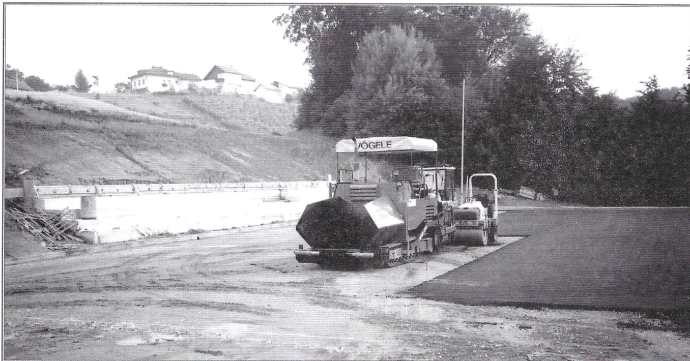
Asfaltiranje odprtega športnega igrišča Vitomarci.
