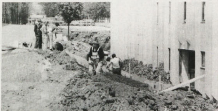
V novi hali kodranke je živahno, nič drugače pa ni tudi pred stavbo. Delavci delajo, da bi bilo vse narejeno tako, kot je dogovorjeno. (Foto: J. Zele)
