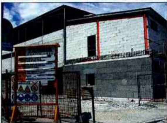
Obnova športne dvorane na Podnu bo vredna nekaj več kot 400 milijonov tolarjev, zaradi sprememb prvotnih načrtov pa se bo zavlekla vsaj za nekaj tednov.
