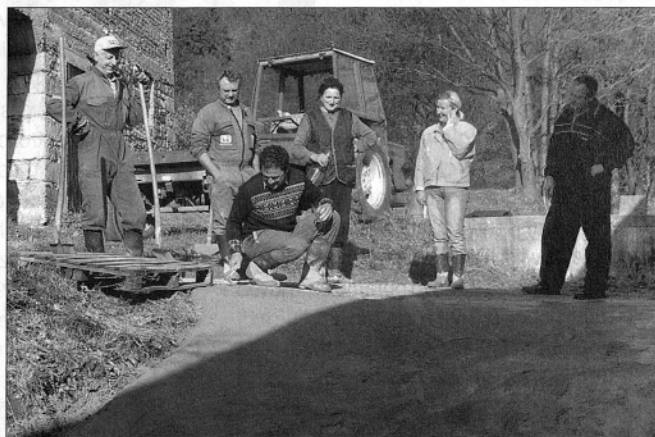
Luknjo na prehodu iz makadama na asfalt so domačini zapolnili z betonom (foto: Benjamin Kanjir)
