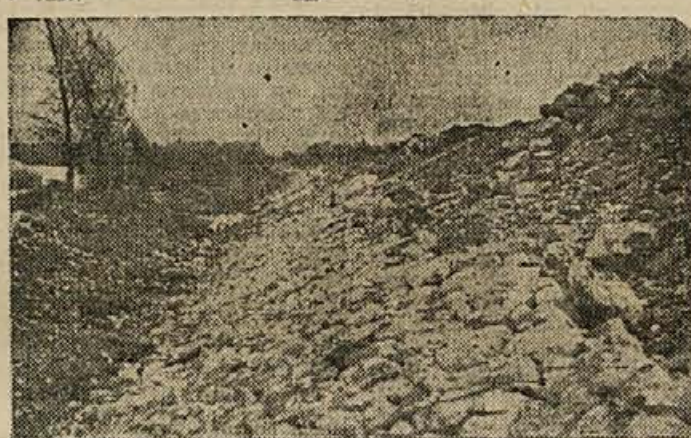
S-vski nasip, ki bo ščitil desni breg Save pri Čatežu in Čateških Toplicah pred poplavi
