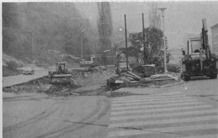
Gradnja se je začela.
