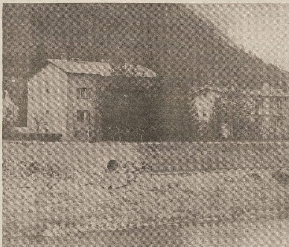
Ko so s prekopom obrežnega nasipa iz Lisc spustili vodo nazaj v Savinjo, so položili v nasip debele betonske cevi.
