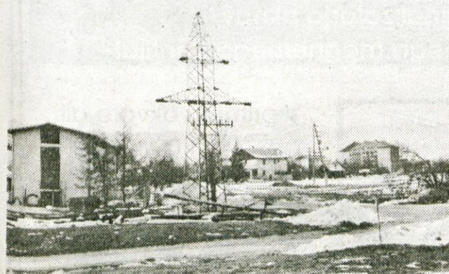
Trgovina Plinstala z Jesenic v Radovljici je v smeri od Doma starostnikov proti Knjigovoznici. Na sliki je v stavbi točno na sredini med Skladiščem Elektro (levo) in Domom starostnikov (desno).
