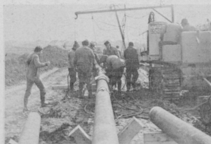
Delavci varijo cevi po specialnem postopku „Fallnaht“ in „Vertical Down“
