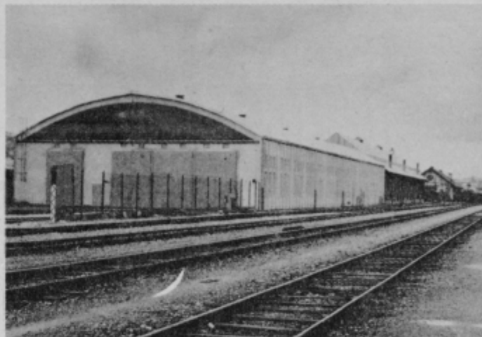
Nova proizvodna hala TOZD za vzdrževanje voz v Ptuj
