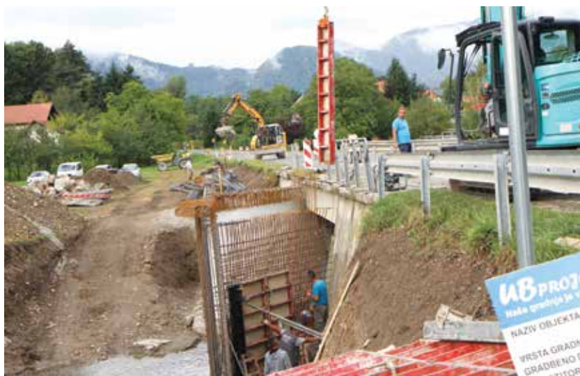
Gradnja mostu čez potok Bolsko v Brodeh
