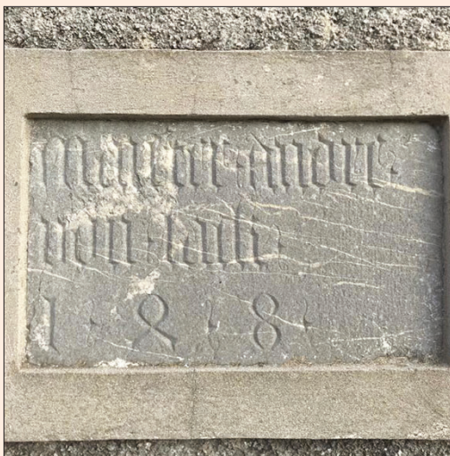
Prva cerkev je stala že v 15. stoletju, kot prča plošča, vgrajena v zid, na kateri je kot graditelj naveden Andrej iz Loke z letnico 148? (manjka zadnja številka).
