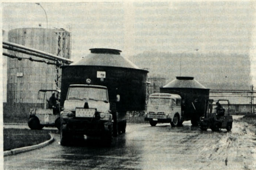
SPODNJI DEL LURGI FILTRA V PREMERU 4,86 m in višini 3,20 m.
