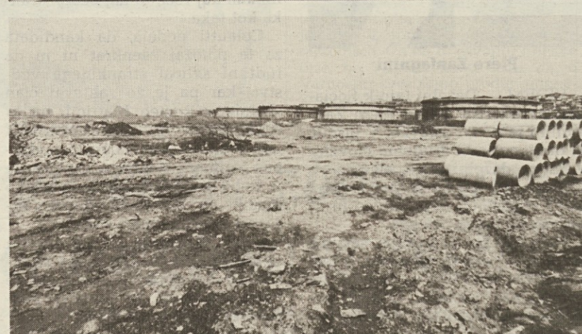
Na zgornjem posnetku je detajl proizvodnega naselja Valdadije pri Ospu, spodaj pa pogled na območje doline pri Orehu, kjer poteka prva tranša urbanizacijskih del (Foto Križmančič)
