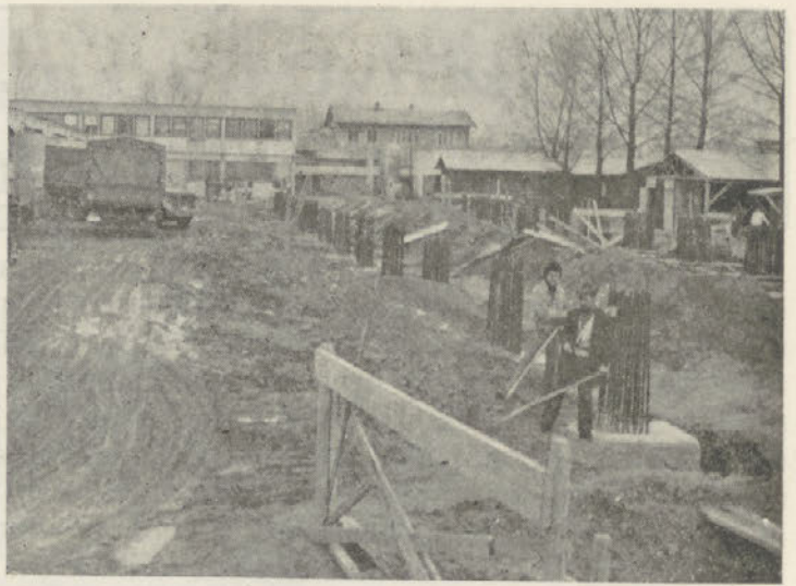
Gradnja temeljev za novo halo
