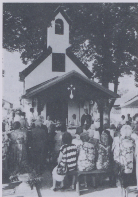
Blagoslovitev obnovljene kapele v Lukačevcih
