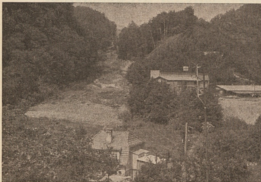
V začetku junija tega leta je zemeljski plaz na območju bivšega obrata Dol napravil precejšnjo škodo. Nkladalci in tovarnjaki so vsak dan angažirani pri odvažanju plazečega materiala.
