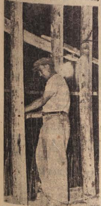
Delavec veže armature za betonske cisterne v vinski kleti v Dobrovem, ki bo popolnoma dograjena do prihodnje jeseni, zdaj pa je urejen soradni obrat
