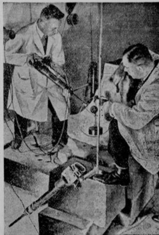
Znanost za delavca: Dva znanstvenika preizkušata kladivo s stisnjenim zrakom, ki v obratu ne odbija. Pokazalo se je namreč, da delavci, ki ravnaajo s kladivi na stisnjeni zrak, kmalu obole na členkih. Preiskave so dognale, da povzročajo obolenje odbojni sunki kladiva.
