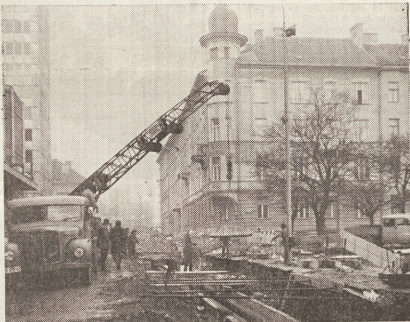
Montaža tunelskih plošč na Dalmatinovi cesti v Ljubljani
